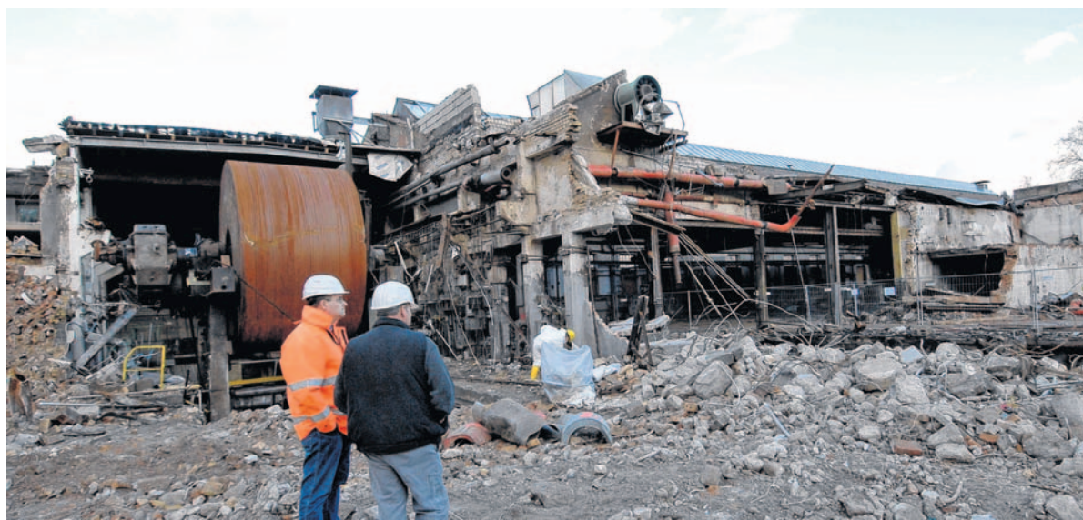
Abbrissarbeiten auf dem ehemaligen Gelände der Papierfabrik Euler.
