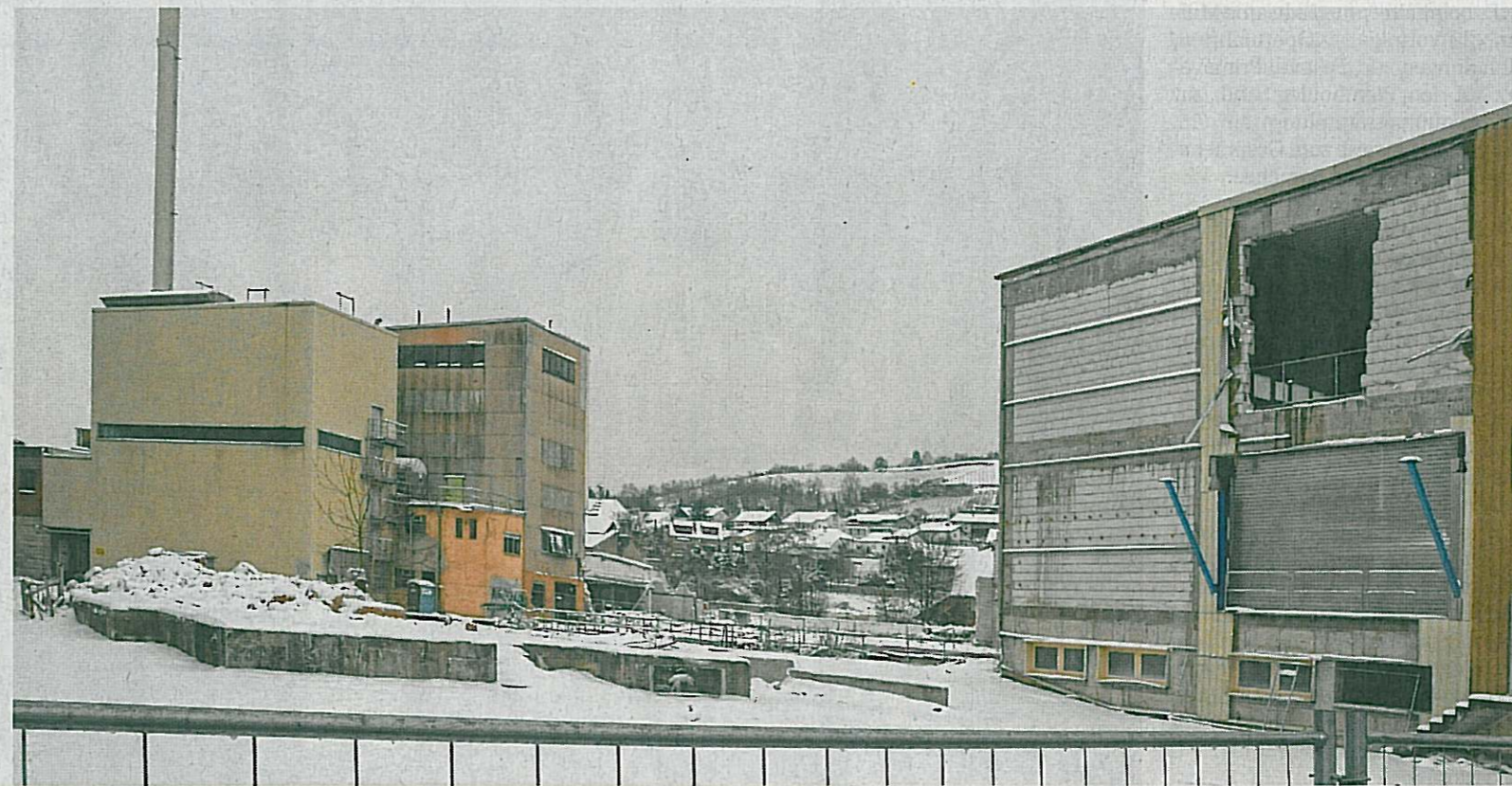
Die Abrissarbeiten auf dem ehemaligen Gelände der Papierfabrik Euler schreiten voran.
