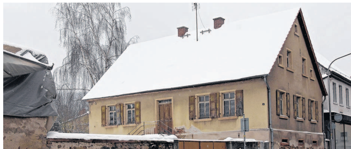
Liegt derzeit brach: der Trautmannshof in der Reichenbacher Ortsmitte.
