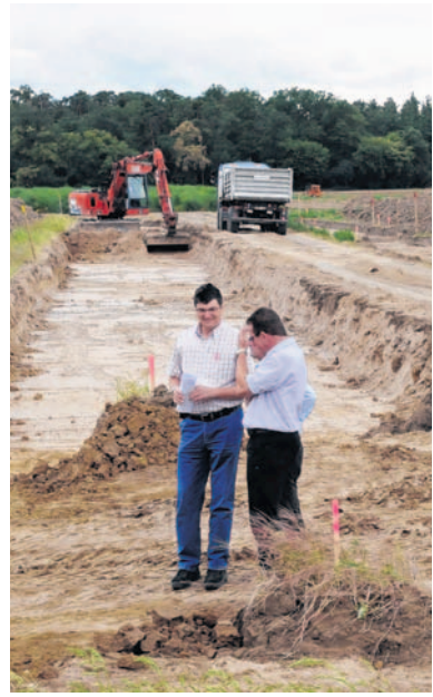
Die Bagger sind schon angerollt.
